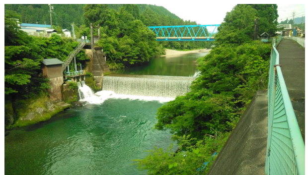
写真3) 数キロ下流の堰。魚道は右側の茂みで見えない。多くの魚には過酷な急勾配である。
