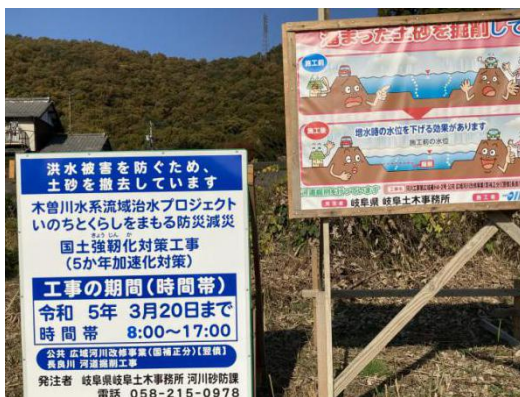
千鳥橋下流側の河原を見る 2022/11/12
