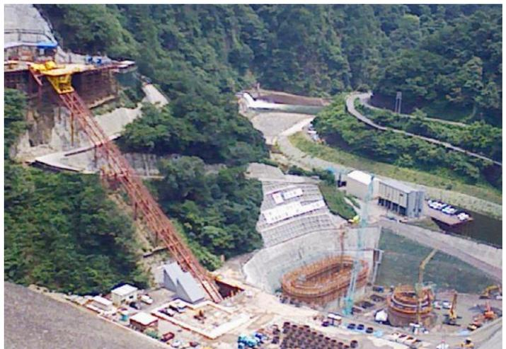
工事中の徳山水力発電所。覆いの建物には手が着いておらず、地下の発電機2機の工事が見える。(2010.8.3 筆者撮影)
