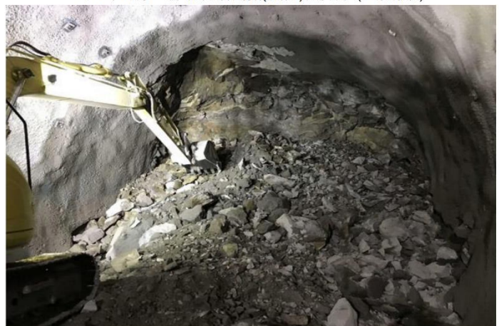
2021年10月27日 瀬戸非常口斜坑崩落(肌落ち)現場写真 (JR東海提供)
