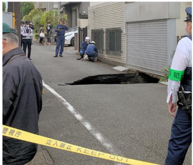
道路の陥没現場では、警察による規制線が張られた=2020年10月18日午後1時過ぎ、東京都調布市東つつしヶ丘2丁目、読者提供
