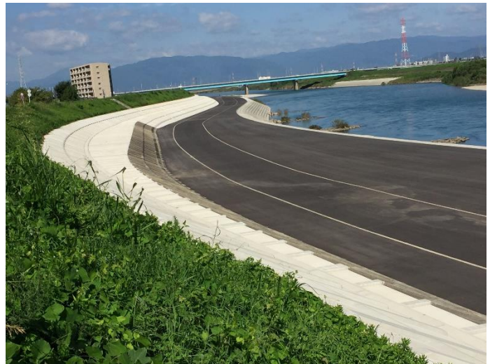
「国土強靱化工事」で変貌する長良川。 左岸（岐阜市本荘）から下流の鏡島大橋を眺める （2021 年 8 月 27 日撮影 武藤）
