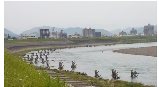
忠節橋下流右岸を下流から望む。 (2021年5月撮影)
