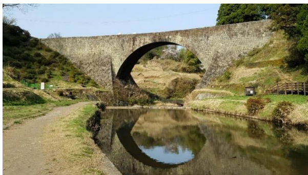
2018 年 3 月 熊本県山都町通潤橋
