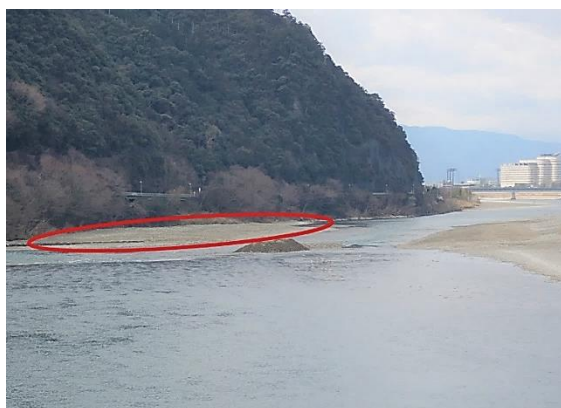
写真 5 岐阜市鵜飼大橋下流の長良川。大きな淵になっていた場所（赤囲い）が完全に埋められている。（2019 年 2 月 16 日撮影）
