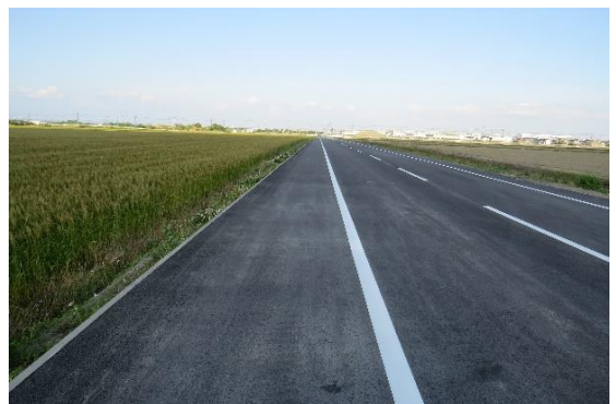
写真 4 写真 3 の水路があった場所。素掘り水路は道路になった。水田も麦畑になっている。（2020 年 5 月 8 日撮影）
