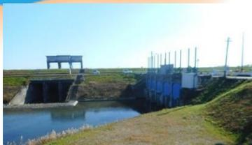
**墨俣** 正面の水門が長良川に通じ、右手の水門が(輪中を切り割らずに)長良川本堤に沿って開削された新犀川に通じる。
