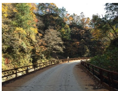
2015/11/12 転流工事現場調査 (ダムサイト上流側)
