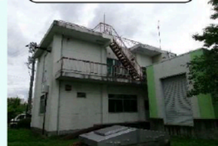
柳津水源地管理棟(現在)
