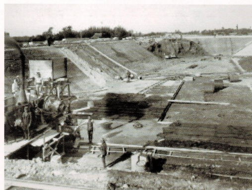
鳥居松村(現春日井市)地内沈澱池コンクリート工事
