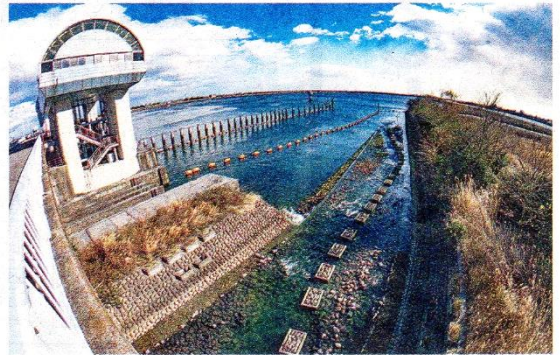
河口堰の右岸側に設置された「せせらぎ魚道」。自然の川の流れを模している
