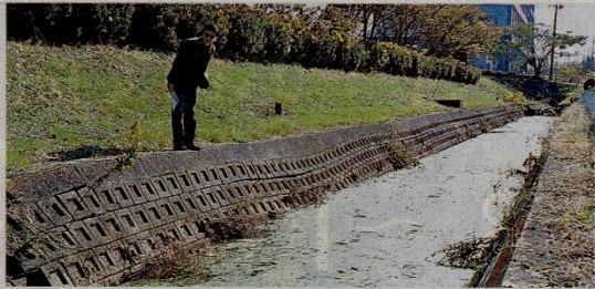
波打つ土手のコンクリートブロックを見る参加者。背中後ろが長良川＝海津市
