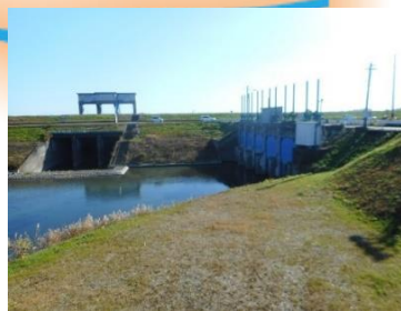
墨俣 正面の水門が長良川に通じ、右手の水門が（輪中を切り割らずに）長良川本堤に沿って開削された新犀川に通じる。
