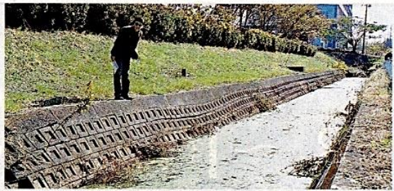
波打つ土手のコンクリートブロックを見る参加者。背中の後ろが長良川＝海津市
