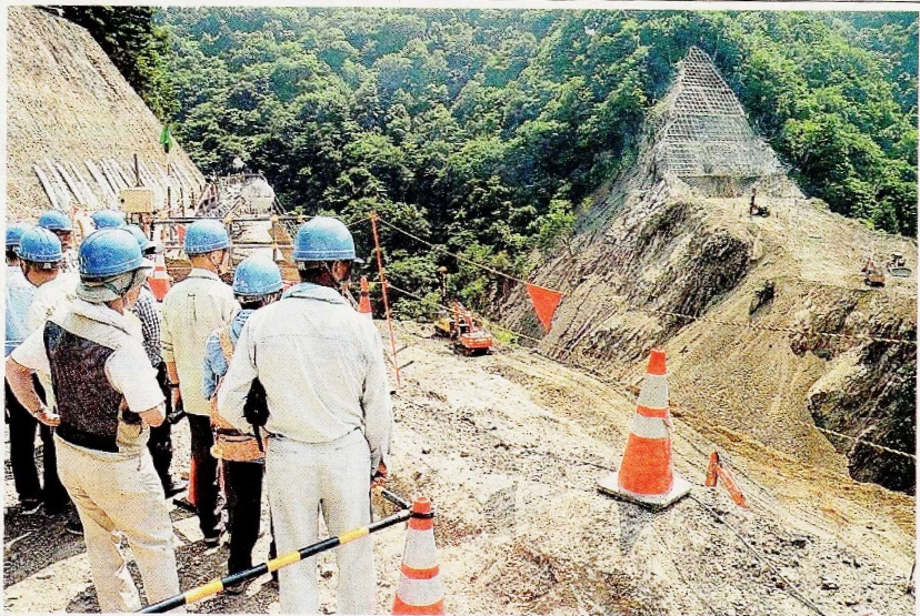
内ヶ谷ダムの工事現場を見学する市民団体のメンバーら＝郡上市大和町内ヶ谷
