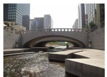
「清流」だった。水源はハンガンとの説明があった。興味があったので、後日某サイトを覗くと「日量 12 万トンの水が流下するよう設計されている。水源は漢江（ハンガン）の水を清溪川専用の浄水場からポンプアップして流下する 9 万 8 千トン、さらにソウル市内を走る地下鉄駅の湧水 2 万 2 千トンによってまかなわれている。」とあった。かなり電気を使っているようだ。
