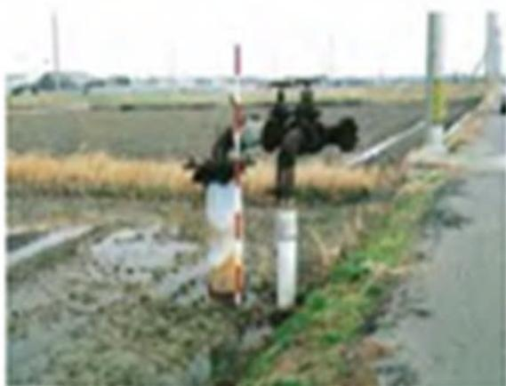
地盤沈下による井戸の上げより状況（木曾町）
